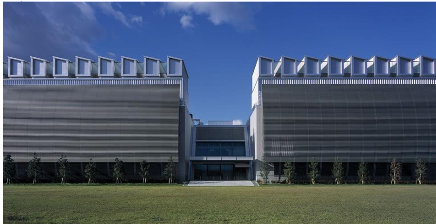
IDCフロンティア 「白河データセンター」
